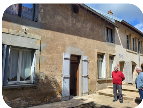
façade sur cour
